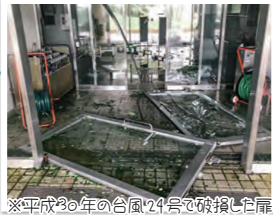
※平成30年の台風24号で破損した扉
