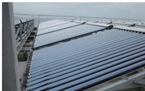
実測調査予定の大規模太陽熱温水器(触媒循環型間接加熱方式)
