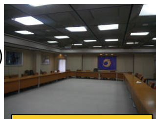
蛍光灯(改修前)
