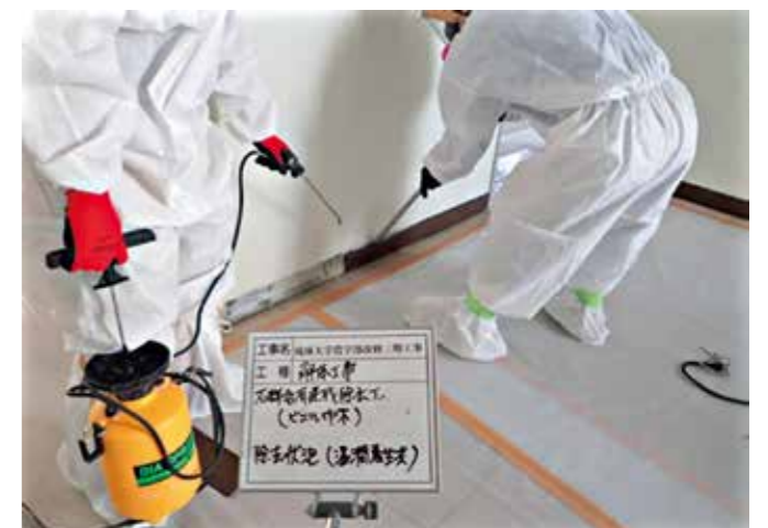
アスベスト含有材の撤去状況
