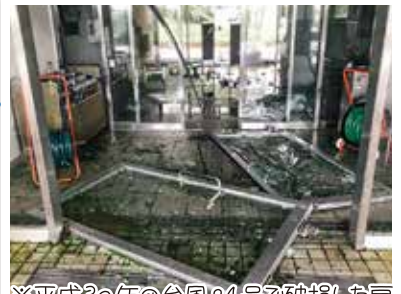
※平成30年の台風24号で破損した扉
