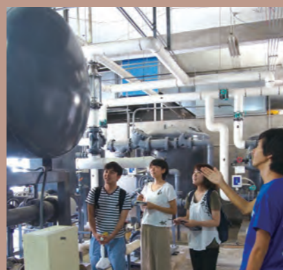
濾過設備 Filtration system
