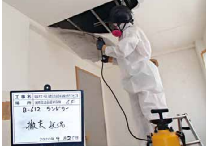
アスベスト含有材の撤去状況
