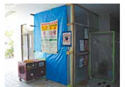
飛散防止対策状況（撤去作業中表示）
