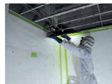
アスベスト含有材の撤去状況
