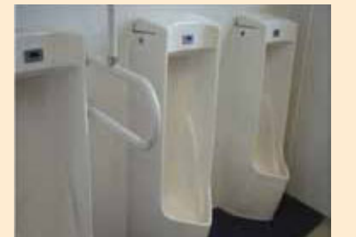
千原団地の各建物便所の洗浄水として有効利用。
