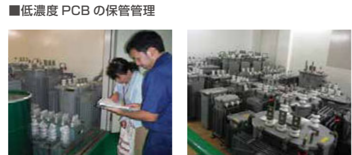
沖縄県南部福祉保健所によるPCB廃棄物保管状況現場調査 保管・管理状況
