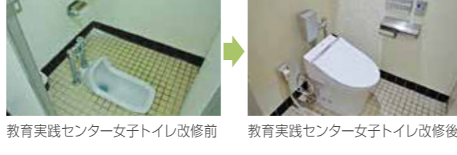
教育実践センター女子トイレ改修前 教育実践センター女子トイレ改修後
