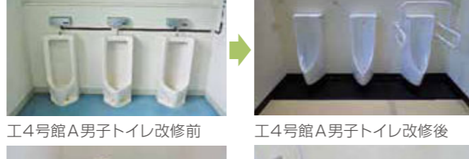
工4号館A男子トイレ改修前 工4号館A男子トイレ改修後
