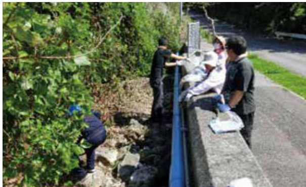
ループ道路（千原池）周辺での作業状況
