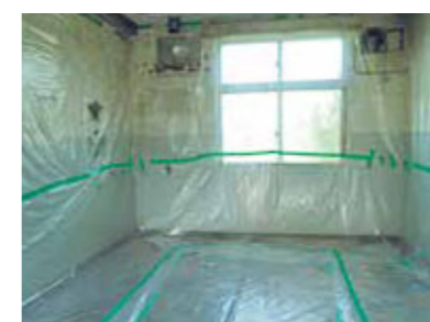
撤去時の飛散防止対策状況
