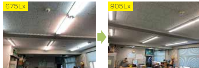
675Lx 実験室蛍光灯(改修前) 905Lx 実験室LED器具(改修後)
