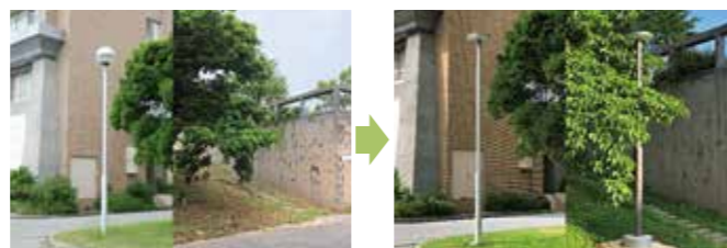
外灯(改修前) 外灯(改修後)
