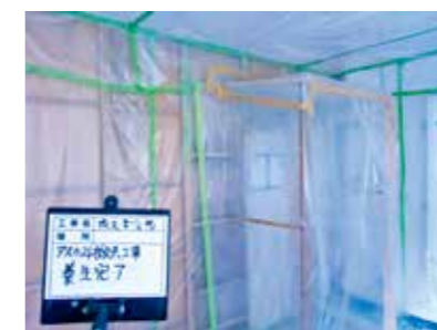
撤去時の飛散防止対策状況
