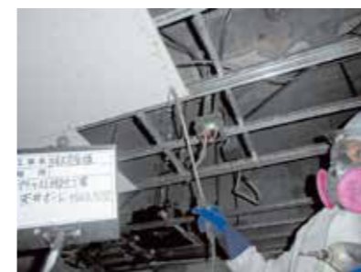
アスベスト含有材の撤去状況
