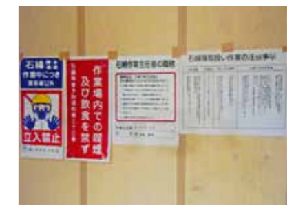
飛散防止対策状況(撤去作業中表示)
