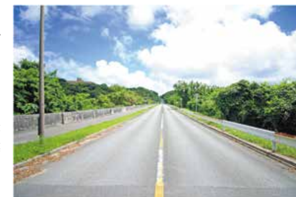
左右が緑に囲まれた琉大敷地内のループ道路
