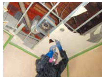
アスベスト含有材の撤去状況
