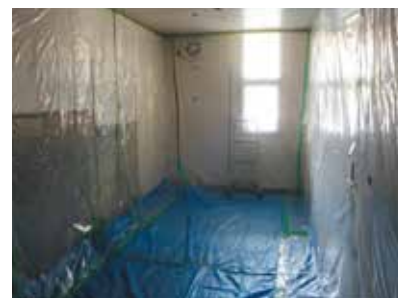
撤去時の飛散防止対策状況
