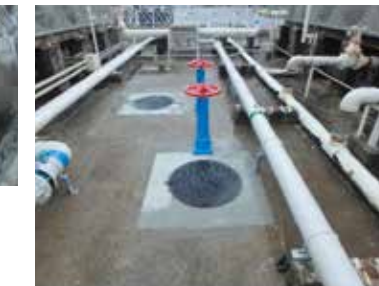
緊急遮断弁 地震を感知してバルブを閉鎖し、保有水の流出を防ぎます。
