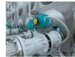
緊急遮断弁 地震を感知してバルブを閉鎖し、保有水の流出を防ぎます。
