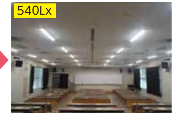
講義室 LED器具(改修後)
