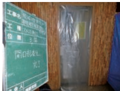
撤去時の飛散防止対策状況
