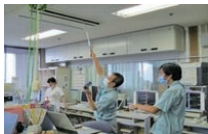
ナースステーション空調吹き出し口の温度調査
