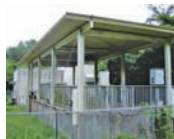
圧送ポンプ場
