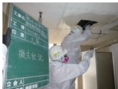
アスベスト含有材の撤去状況
