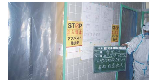
撤去時の飛散防止対策状況
