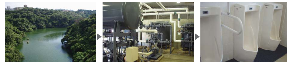
千原地区に降った雨は、ほぼ中央に位置する千原池に集まる。専用の濾過装置にて、濾過・消毒処理をする。千原地区の各建物トイレの洗浄水として有効利用
