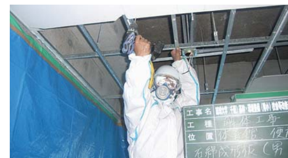
アスベスト含有材の撤去
