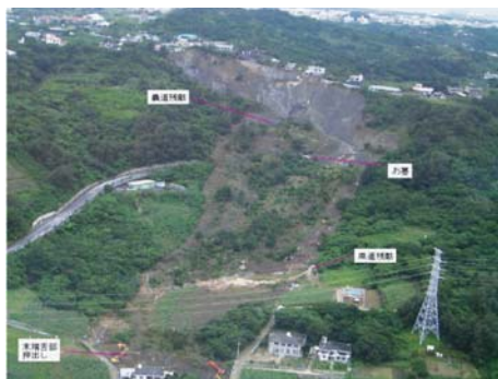
写真2 安里地すべりの全景
