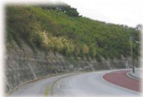
工事着手前全景 (2011.2撮影)
