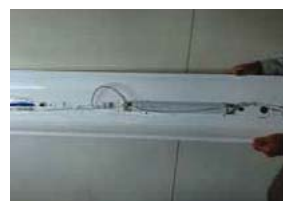
写真4 インバーター照明器具
