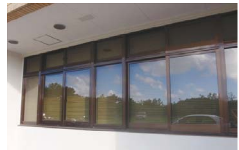
新設された熱線反射ガラス (見た目は普通のガラスと同じです。)
