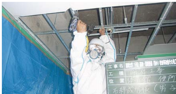
アスベスト含有材の撤去
