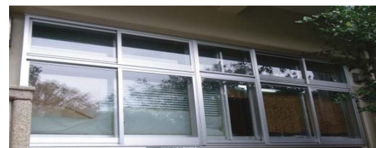
改修後の二重サッシ
