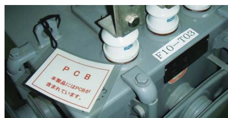
微量PCB混入を示す表示札
