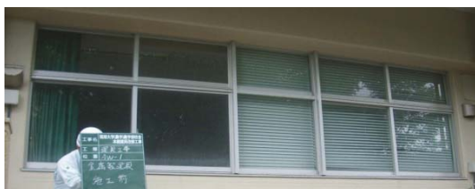
改修前の通常の窓
