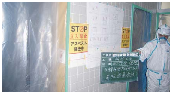
撤去時の飛散防止対策状況
