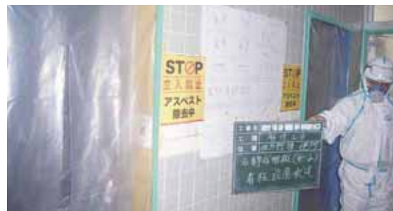
撤去時の飛散防止対策状況
