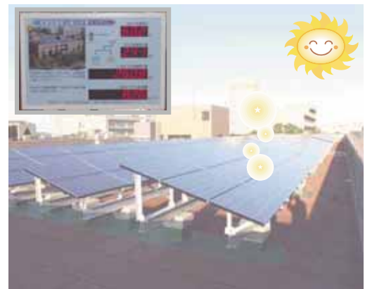
附属図書館屋上
