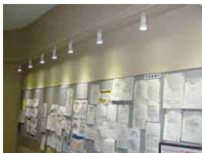
玄関ホールLED照明設置
