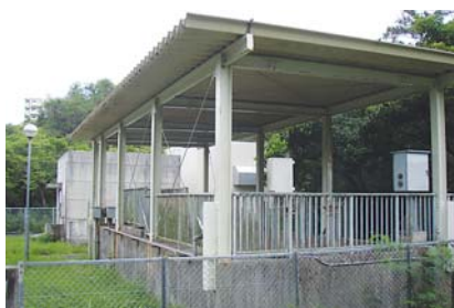
公共下水道へ排水をする圧送ポンプ場
