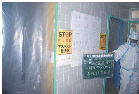
撤去時の飛散防止対策状況
