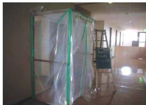
アスベスト含有材の撤去時の飛散防止対策状況
