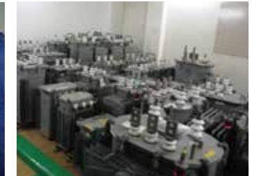
保管・管理状況
