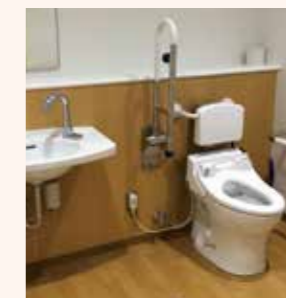
トイレの洗浄水
