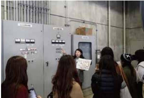
中央設備機械室で説明中
