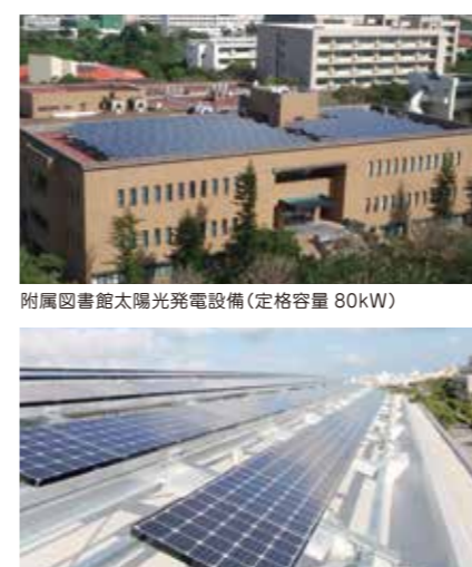
おきなわクリニカルシミュレーションセンター 太陽光発電設備(定格容量20kW)
