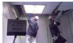
アスベスト含有材の撤去状況
