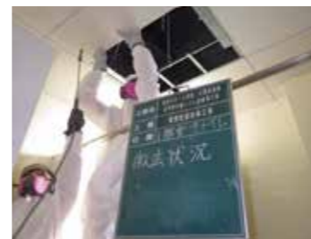
アスベスト含有材の撤去状況
