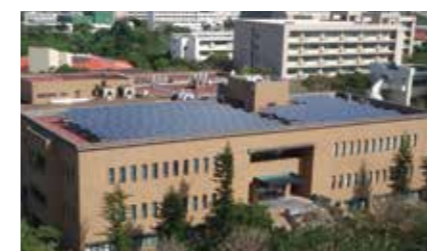
附属図書館太陽光発電設備(定格容量80kW)
