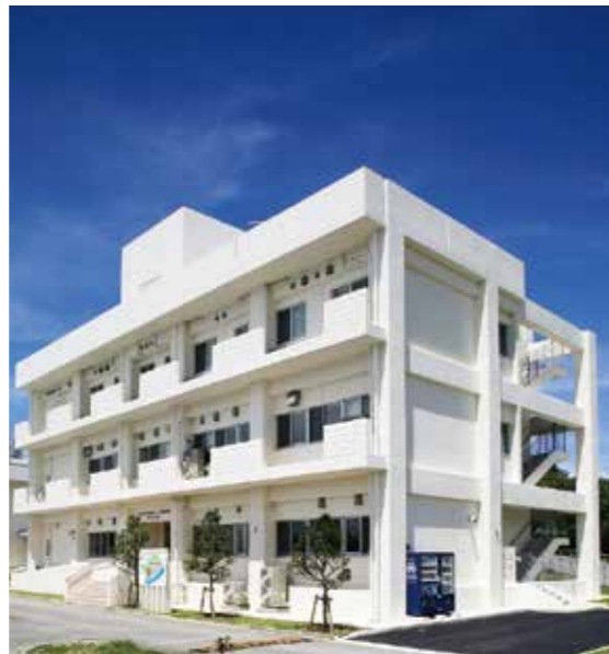
瀬底研究施設 新管理棟
