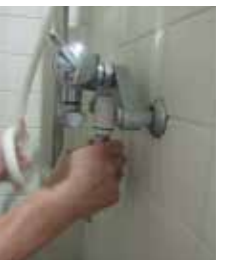
環境整備課によるシャワーヘッド交換
