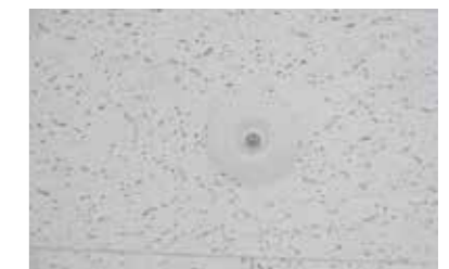
廊下の人感センサー: 人を感知した時だけ点灯します
