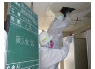
アスベスト含有材の撤去状況
