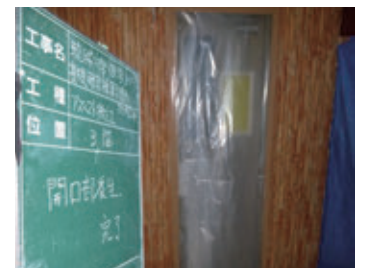
撤去時の飛散防止対策状況
