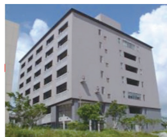
機器分析施設・化学物質管理室
