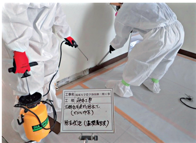
アスベスト含有材の撤去状況
