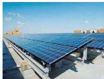
附属図書館の屋上に設置した太陽光発電設備
